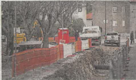
Izmijenit će se dotrajale vodovodne cijevi u dužini 360 metara i još 220 metara kanalizacijskih cijevi, redom položenih prije 50 i više godina
